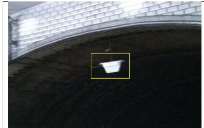
Figure 11. Position de l'antenne (bout du quai) à la station "Les Sablons" (Rapport de mesure R_SO8122_1_15)
